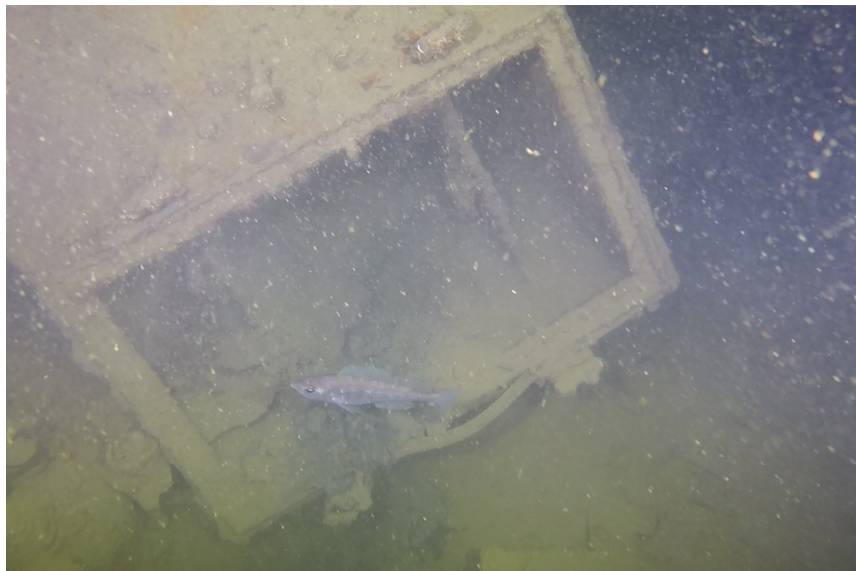
Рис. 2. Поврежденные металлические конструкции в центральной части судна
