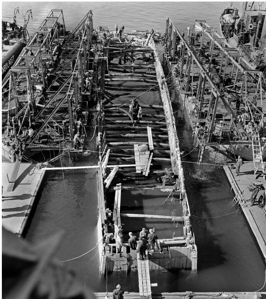
Рис. 2. Процесс подъёма «Вазы»
